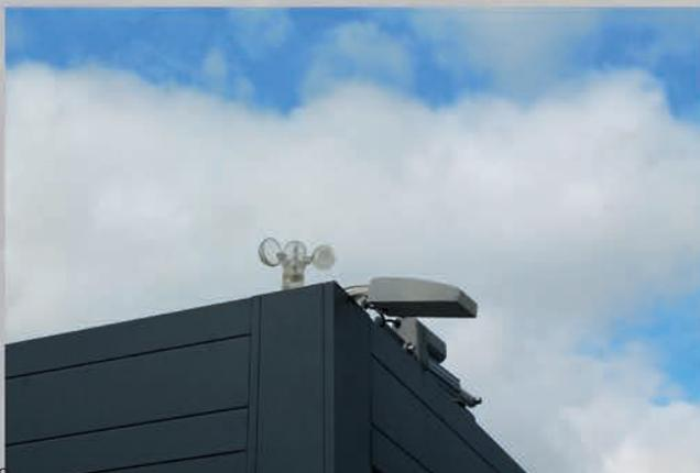
Permet de gérer l'orientation des lames en fonction du vent, de la pluie, de la neige et du gel.
